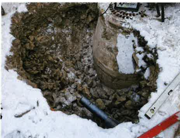
Et par bilder av utbedringen, som viser rør fra kum ført under veien for å få vannet bort fra parkeringsarealene.
