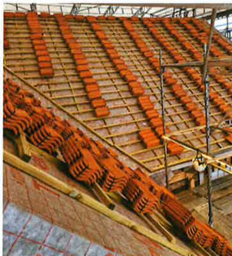
Bilde: Taksteinen løftet opp på kirketaket
