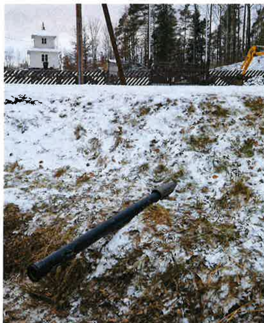
Et par bilder av utbedringen, som viser rør fra kum ført under veien for å få vannet bort fra parkeringsarealene.
