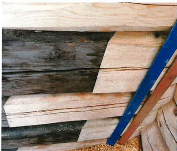
Bilde: utsnitt av laftearbeideri et hjørne på Bamble kirke, hvor nytt og gammelt laft møtes.
