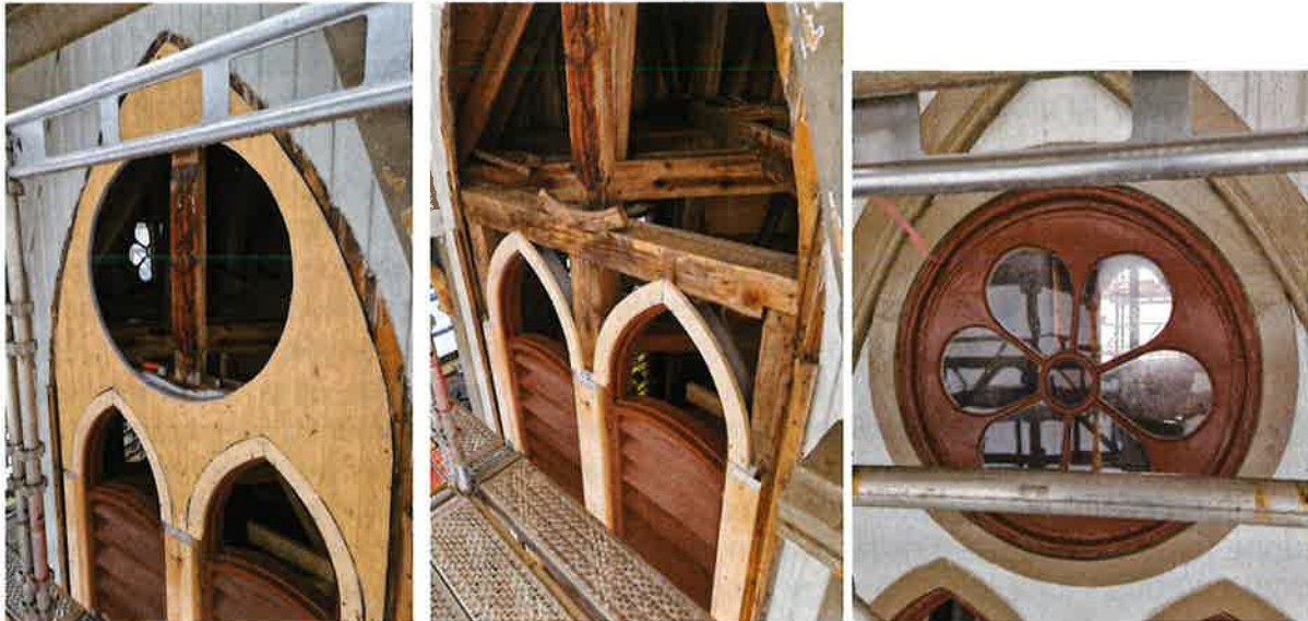
Bilder: Utbedring av sjalusi ved kirkeklokkene og rosevindu
